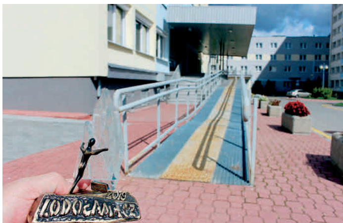
Podjazd do Domu Studenckiego Asystent. Modernizując nasze akademiki dbamy o potrzeby osób z niepełnosprawnością.
