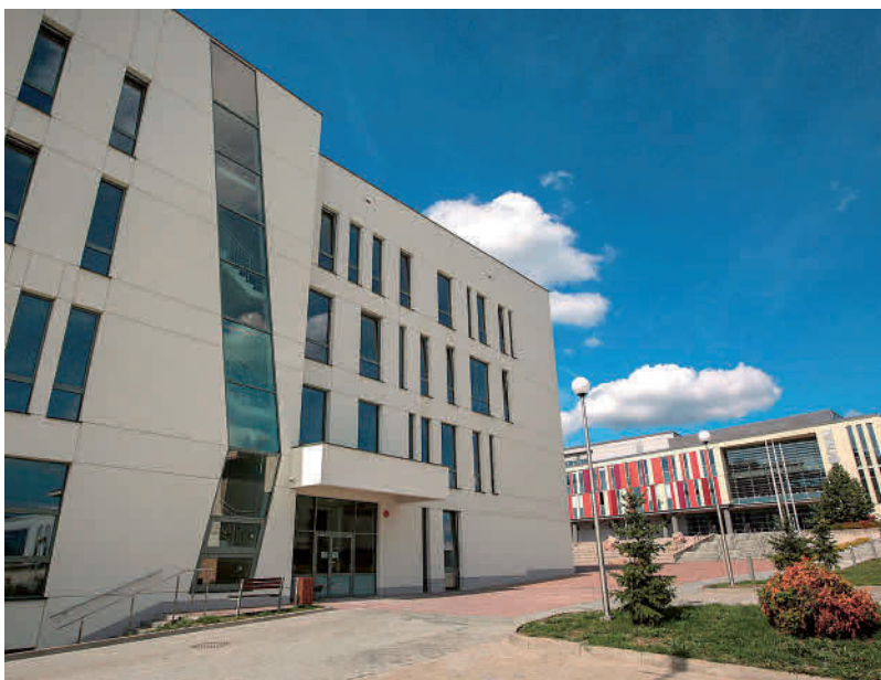
Sierpień 2019 roku. Gotowy jest już budynek Centrum Edukacji Medialnej i Informacji Naukowej. Wkrótce przeniosą się do niego studenci i pracownicy Wydziału Humanistycznego UJK.
