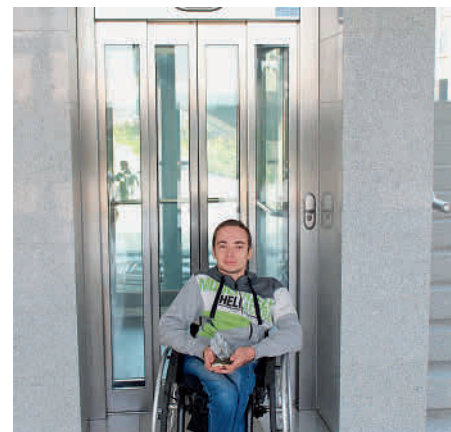
Winda w budynku Centrum Przedsiębiorczości i Biznesu UJK przystosowana jest do potrzeb osób z niepełnosprawnością.
