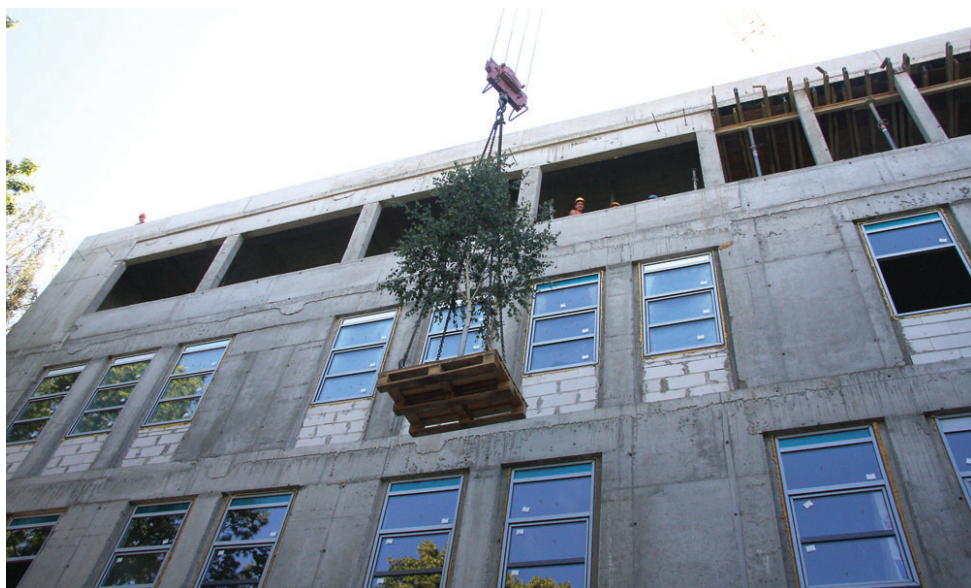
Budynek na potrzeby medycyny został już przykryty, montowane są już okna.
